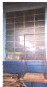
VENTANAS, SUSTITUICION DE VENTANAS EN MAL ESTADO
