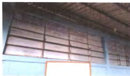
VENTANAS, SUSTITUICION DE VENTANAS EN MAL ESTADO
