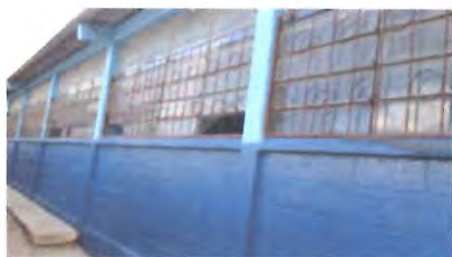
VENTANAS, SUSTITUCION DE VENTANAS EN MAL ESTADO
