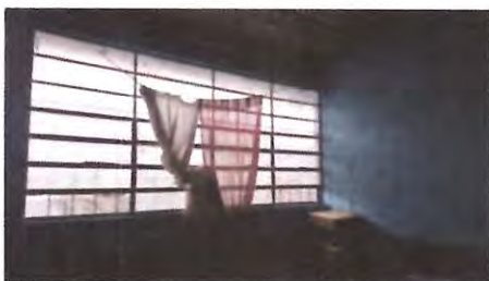
VENTANAS, SUSTITUCION DE VENTANAS EN MAL ESTADO
