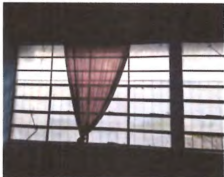
VENTANAS, SUSTITUCION DE VENTANAS EN MAL ESTADO
